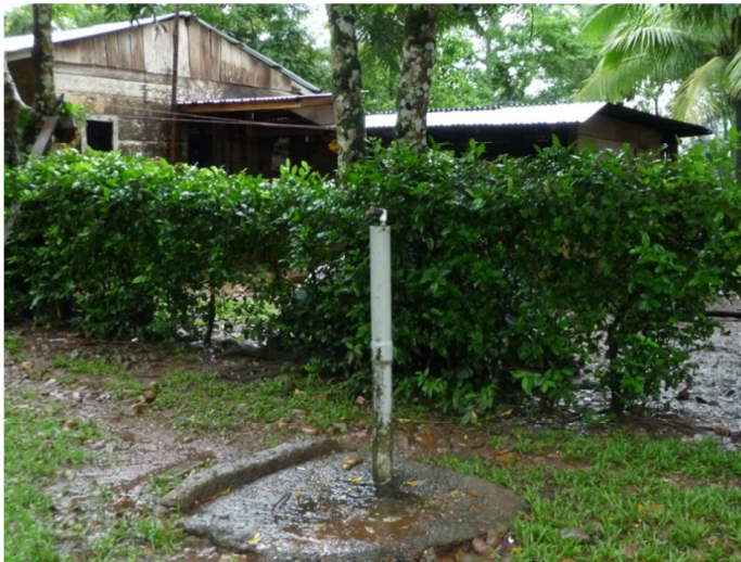
Caño de agua potable en una calle de la Comunidad.
